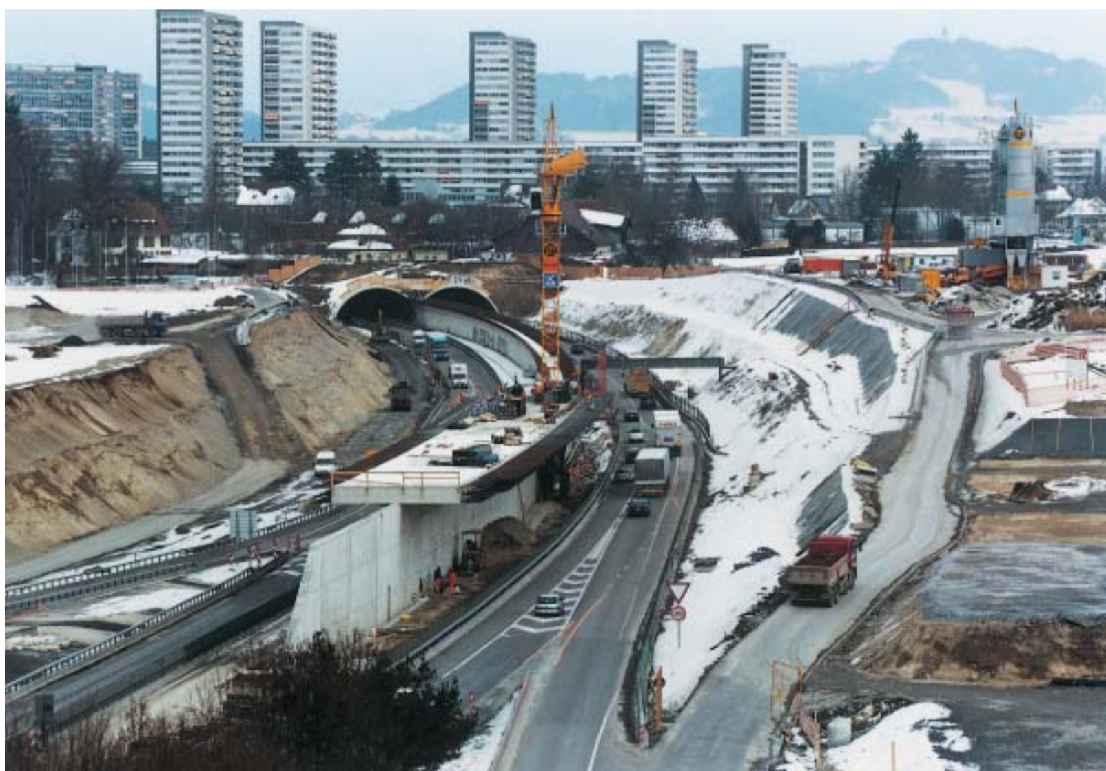
Mit der Tunnelverlängerung und dem Aushub sind die WESTside-Vorarbeiten bereits voll im Gang.
