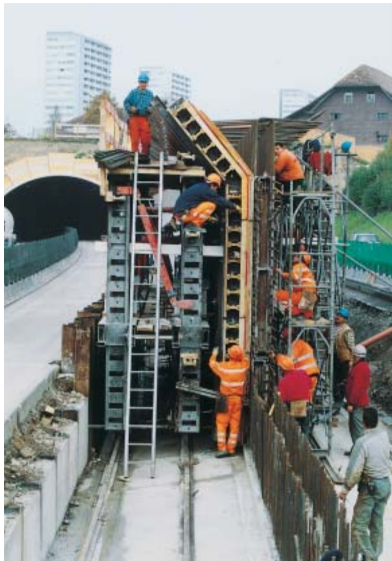
Die Mittelwand wird noch im April fertig gestellt, bis im Herbst 2006 steht der ganze Tunnel-Rohbau.
