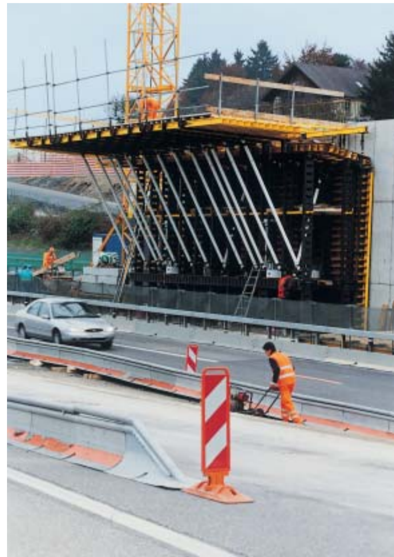
Besondere Herausforderung: Über 30'000 Fahrzeuge passieren täglich die Tunnel-Baustelle.
