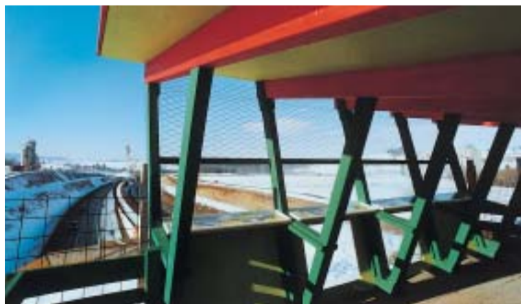
Tägliche Fortschritte: der Blick von der Info-Plattform auf die entstehende Autobahnüberdeckung.
